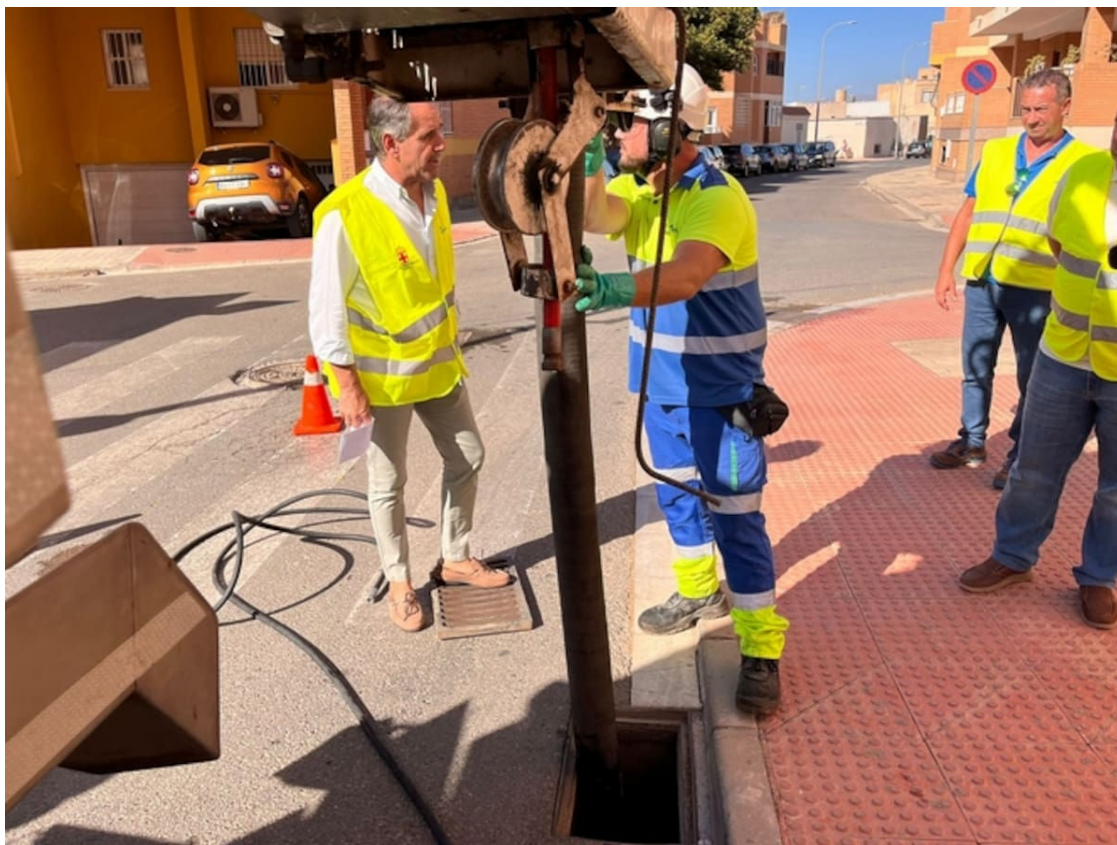
Se han extraído 1,6 millones de litros de residuos de las alcantarillas y colectores de saneamiento.
