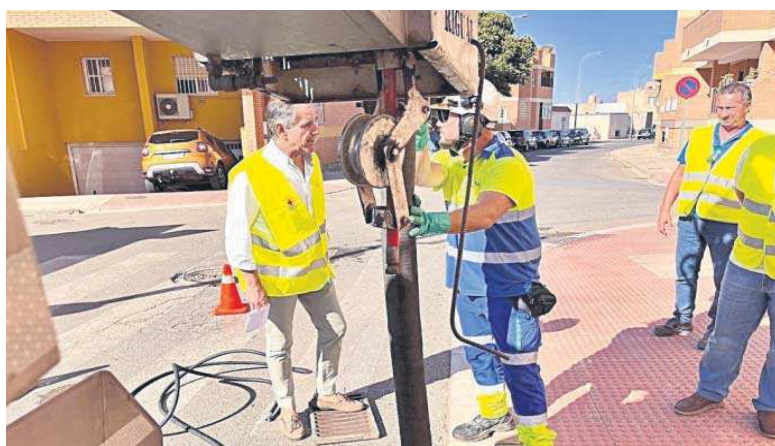
Segura ha visitado a los trabajadores de Aqualia.
